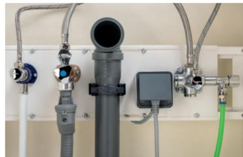
Sauber und übersichtlich montiert: Kalt- und Warmwasser, Abfluss der Spüle, Aufputzsteckdose, Anschluss für Trinkwasserleitung (z. B. für eine Kaffeemaschine mit Festwasseranschluss oder einen Kühlschrank mit Eiswürfelbereiter).
